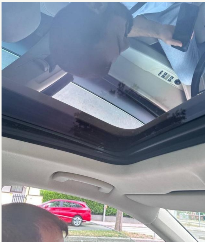
Geöffnetes Dach zur Rahmenprüfung
